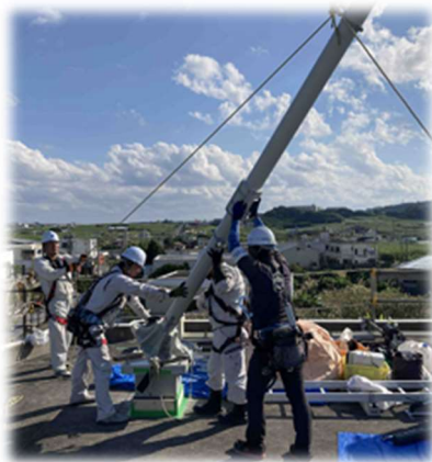
<人力で建柱可能な本支持柱>
